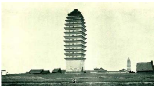
▲唐代慧先寺塔(西寺塔)
